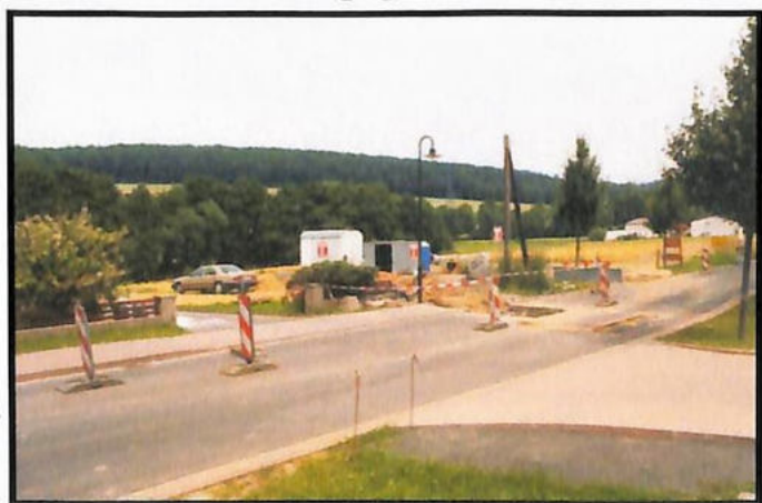
1996 Beginn der Erschließungsarbeiten im Mühlenfeld
