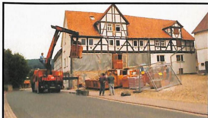
1996 Beginn der Renovierungsarbeiten an der Gaststätte
