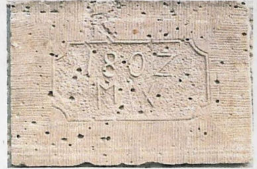
Baustein am Pfarrhaus - 1802
