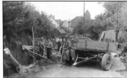
1951 - Kohlenstraße, Bau der Friedhofsmauer
