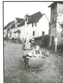
Dorfeingang mit „Trafhäuschen“
