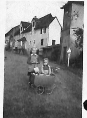
Dorfeingang mit "Traföhäuschen"
