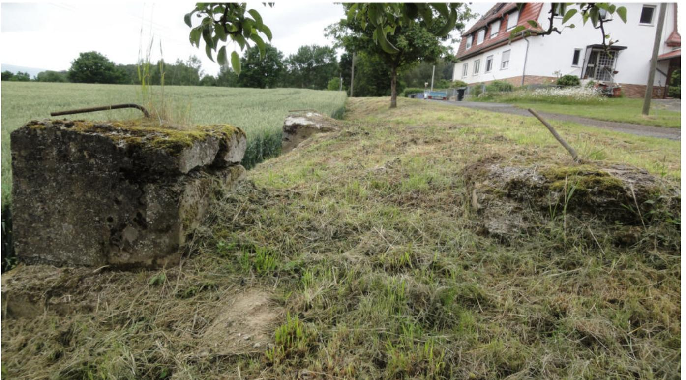
**Mastfundamente der Drahtseilbahn
