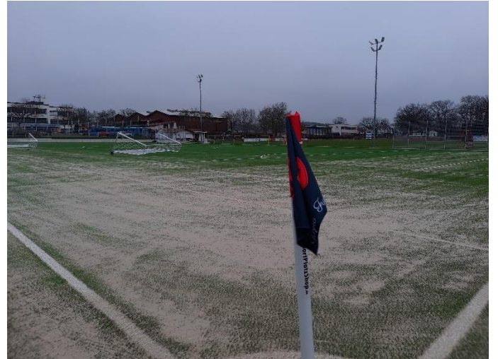
Sand ist zu 75% eingebracht
