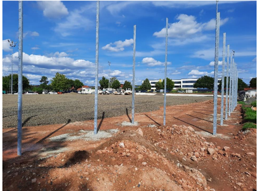
Randsteine und Pfosten für den Zaun werden gesetzt
