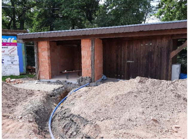
Die Aschenbahn wird entfernt und die Wasserleitungen verlegt, die neue Pumpstation kommt in das Gerätehaus.
