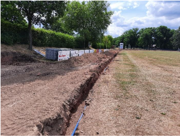
Die Aschenbahn wird entfernt und die Wasserleitungen verlegt, die neue Pumpstation kommt in das Gerätehaus.
