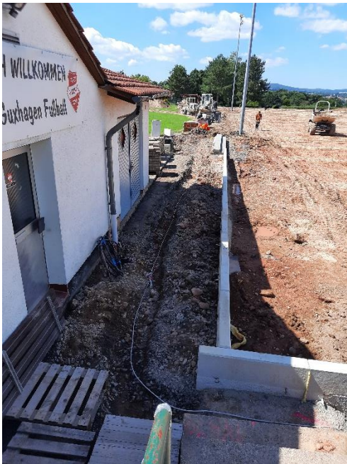
Randsteine und Pfosten für den Zaun werden gesetzt
