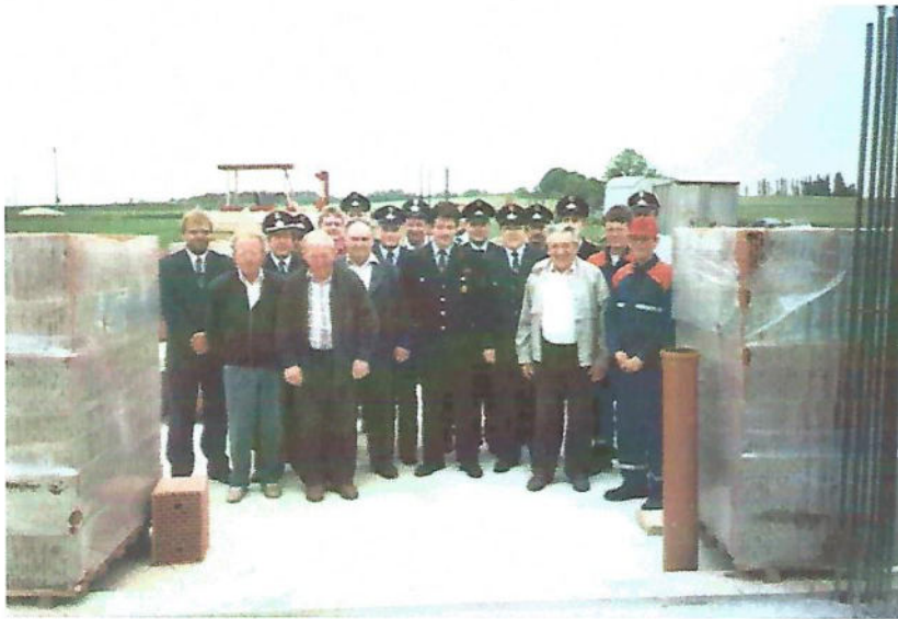
Das Foto zeigt einige „stolze“ Feuerwehrkameraden am Tag der Grundsteinlegung.
