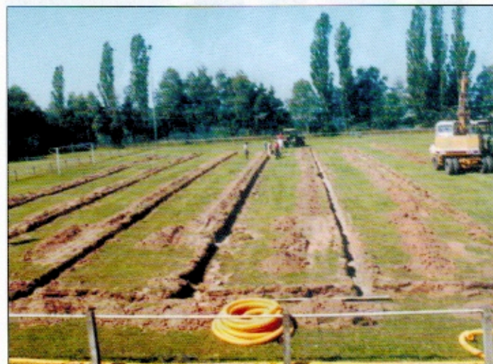
Sanierung der Drainage
