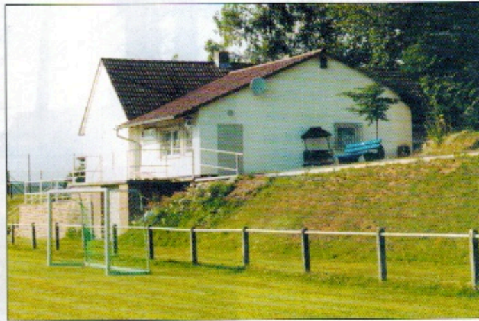
... nach dem Umbau
