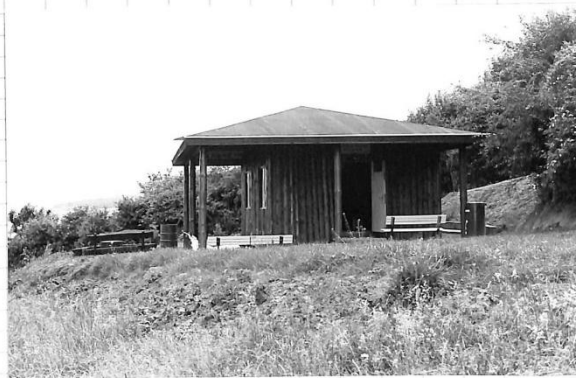
Die Schutzhütte; 1989 in Eigenhilfe erbaut. Das Baumaterial bezahlte die Gemeinde
