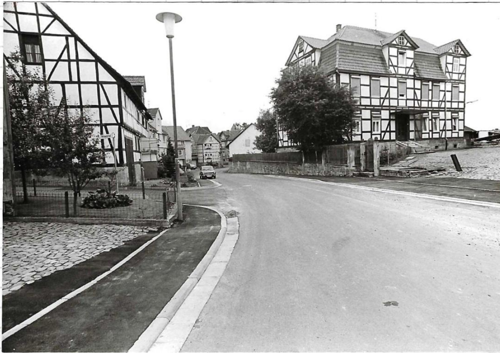
Die Bachstraße (Neubau Kanalisation, Schwarzenbach, Graße (seit 1939))
