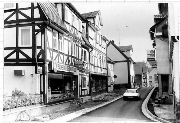
Die Untergasse 1981 Seit 1980 wird die gesamte Ortsdurchfahrt ausgebaut
