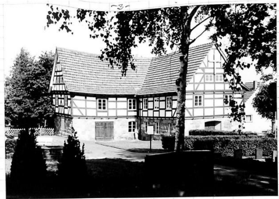
Die Friedhofshalle - auch Winterkirche - wurde 1974 erneuert
