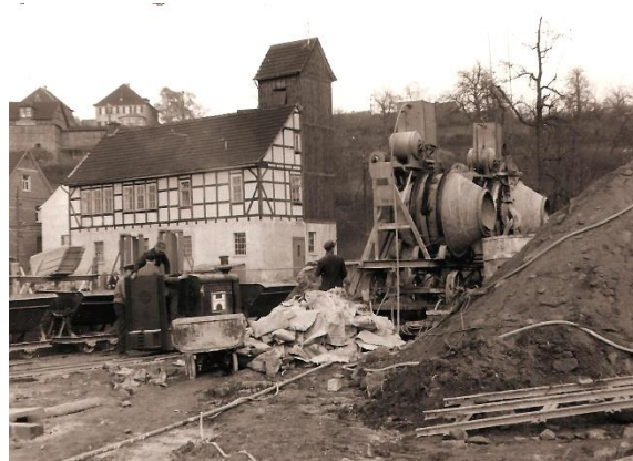
Bauarbeiten vor dem Feuerwehrhaus
