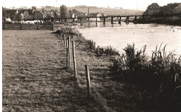
Blick auf die Holzbrücke
