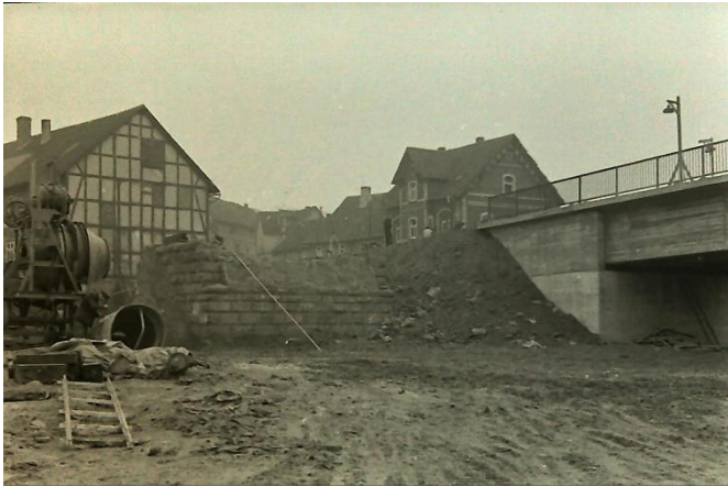
Alte Holzbrücke abgerissen und Neue gebaut
