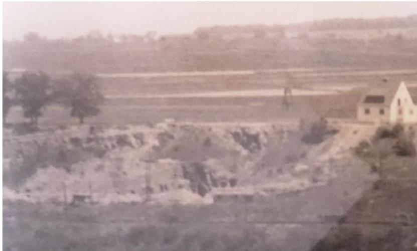
In die Steinwände wurden von oben Löcher gebohrt. Der Seniorchef Heinrich Fromm hatte eine Erlaubnis zu sprengen (Sprengmeister). Er füllte die Löcher mit Dynamit, setzte Zünder ein und verband diese mit Zündschnüren. Rechtzeitig vor der Sprengung waren die Bewohner der an das Steinbruchgelände angrenzenden Wohnhäuser sowie der Bahnhofsvorsteher über die vorgesehene Sprengung informiert worden.
