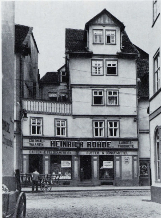
Das Geschäftshaus mit Ladengeschäft 1911 im Hause Leipziger Straße 6
