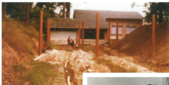
Schießbahn fast fertig
