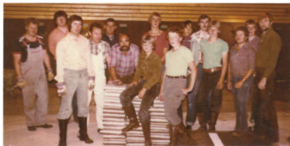
Fliesen legen in der Luftgewehrhalle
