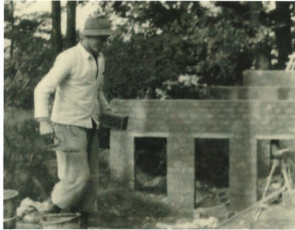
Hans Vogelsberg beim Mauern des ersten KK-Standes
