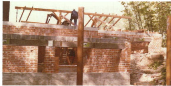
Dachstuhl Errichtung
