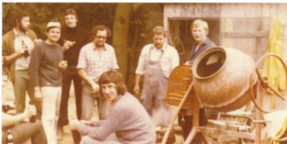
Anfang aufstellen der Baubude, Mischmaschine
