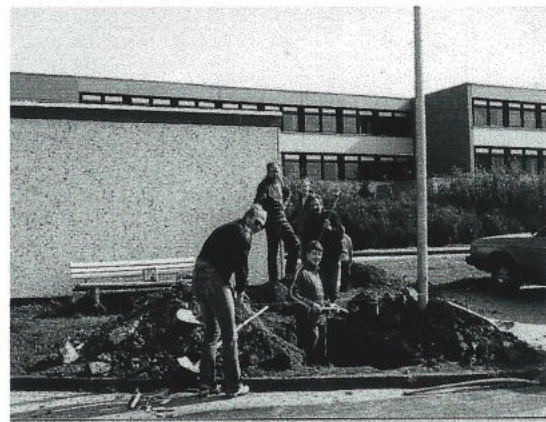
Joachim Vogelsberg, Klaus Schleiter, Klaus Becker, Uwe Bornmann und Holger Lehmann beim Stromverlegen
