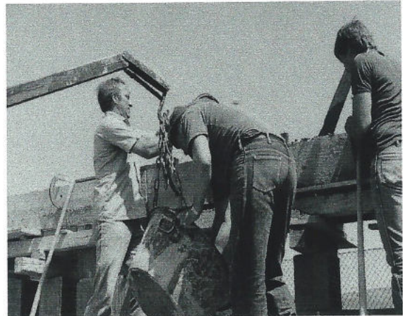
Die Decke wird gegossen
