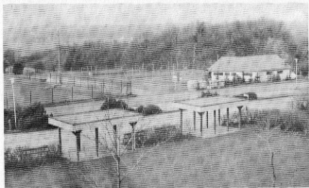
Blick auf die Tennisanlage mit Vereinsheim und vier Plätzen.
