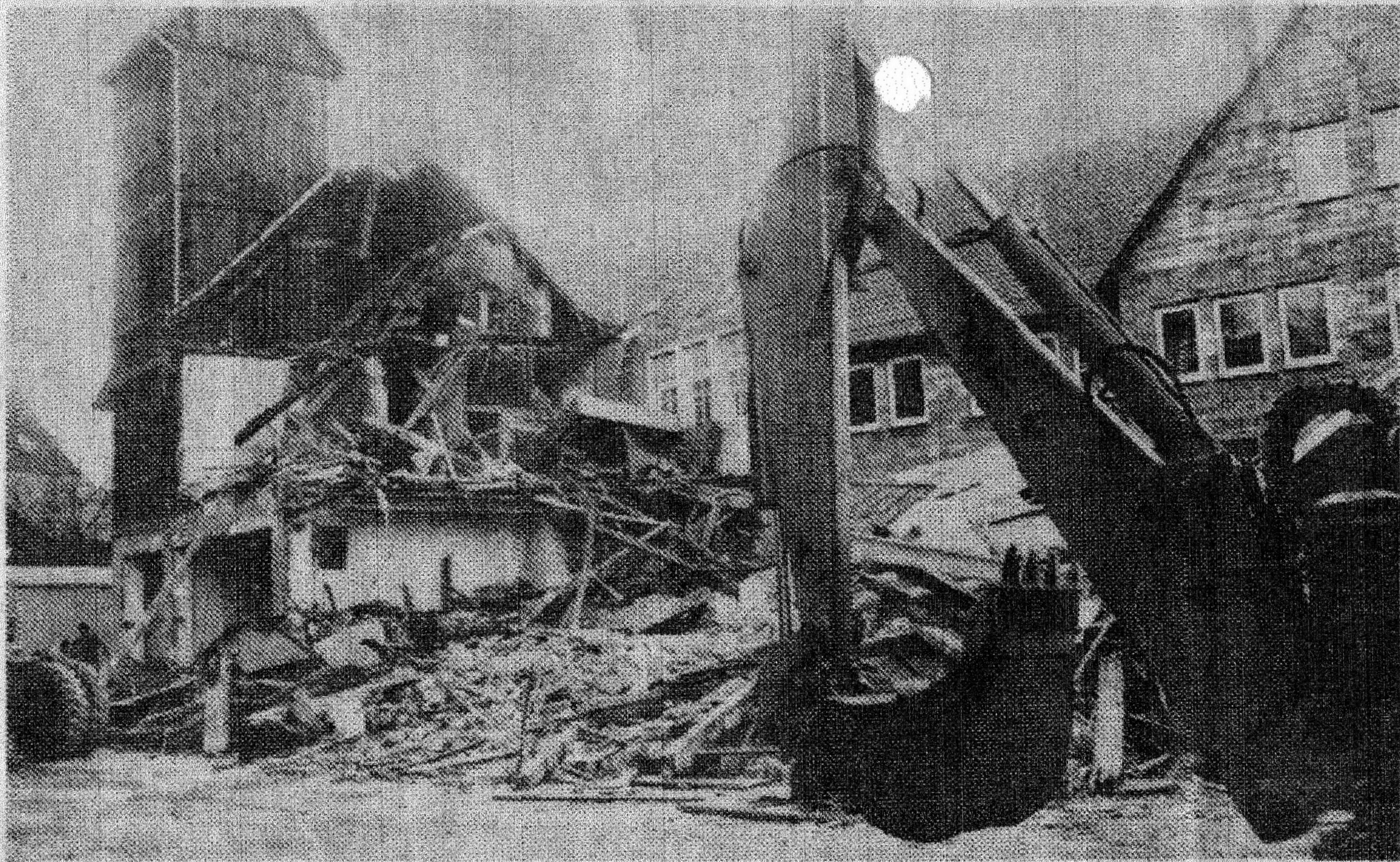
Hinter dem Schuttberg des alten Feuerwehrgerätehauses steht der Neubau der Feuerwache, der in den nächsten Tagen seine Funktion für den Brandschutz übernehmen soll. Vorübergehend wurden die Geräte im neuen Bauhof untergebracht. (Foto: hro)
