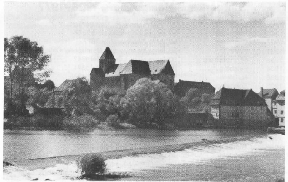
Blick über das Stauwehr der Fulda zur Klosterkirche (hinter der Weide verdeckt das Pfarrhaus)
