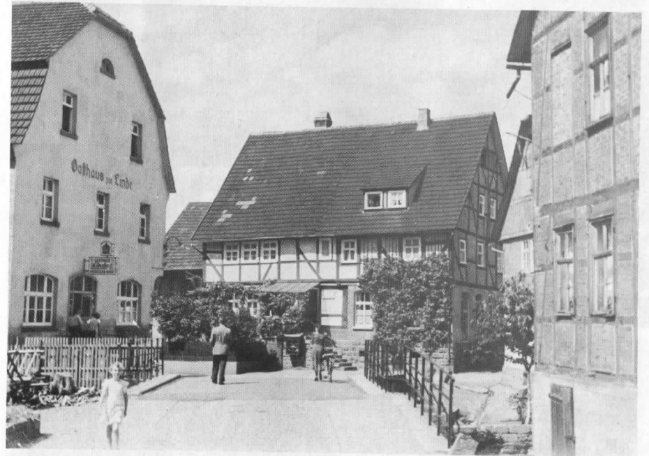
Alte Bachbrücke vor Änderung des Ortskernes
