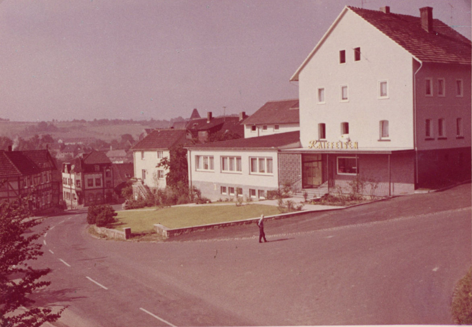
Neubau der Raiffeisenbank nach dem Abriss des Schüppens
