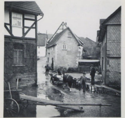
Holzbocker - ein Steg zwischen Fehr u. Jülicher
