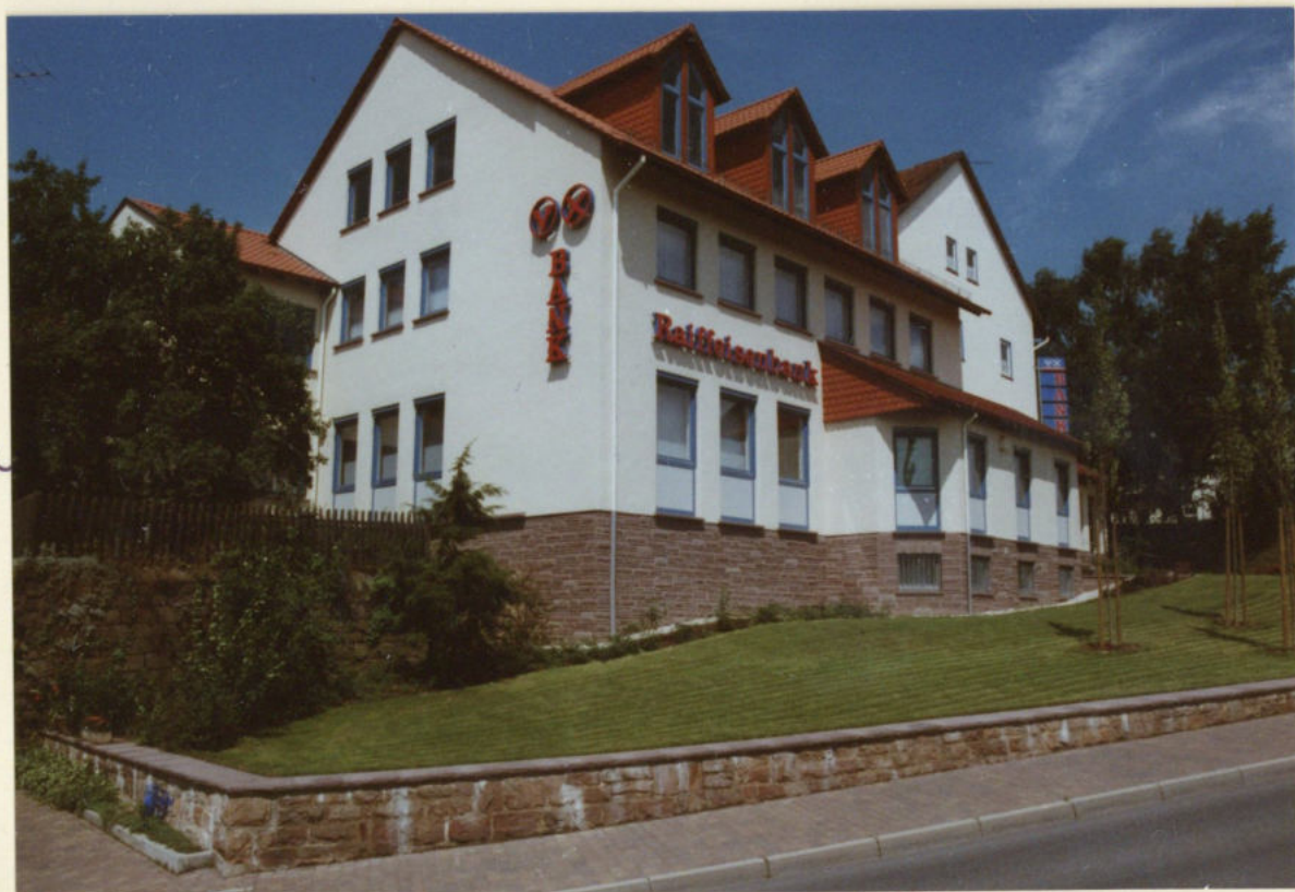
Umbau u. Erweiterung (ca. 1989)
