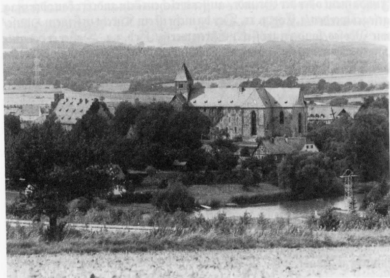
Klosterkirche mit Zehntscheune, Süd- Ost Ansicht
