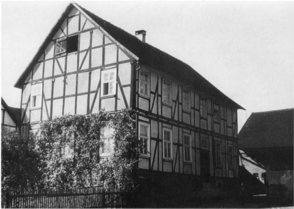
Die „Alte Schule“ in der Brunlarer Straße. 1854—1917 Schule und Lehrerwohnung.
