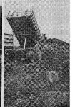
**KNAPP 1400 METER LANG** ist der Lärmschutzwall, der zur Zeit an der Autobahn A 7 bei Ellenberg aufgeschüttet wird. Rund 80 000 Kubikmeter Erde sind dazu nötig. **LKW UM LKW** wird Erde geliefert.
