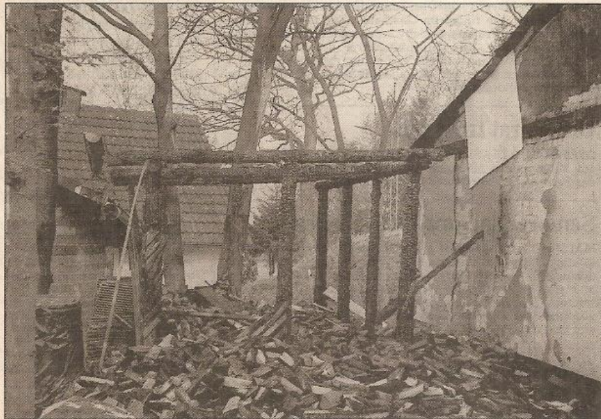
Vom Holzschuppen aus griff das Feuer auf das alte Vereinsheim über. Das neue Gebäude, massiv aus Steinen gemauert, blieb verschont. (Foto: Sinnig)
