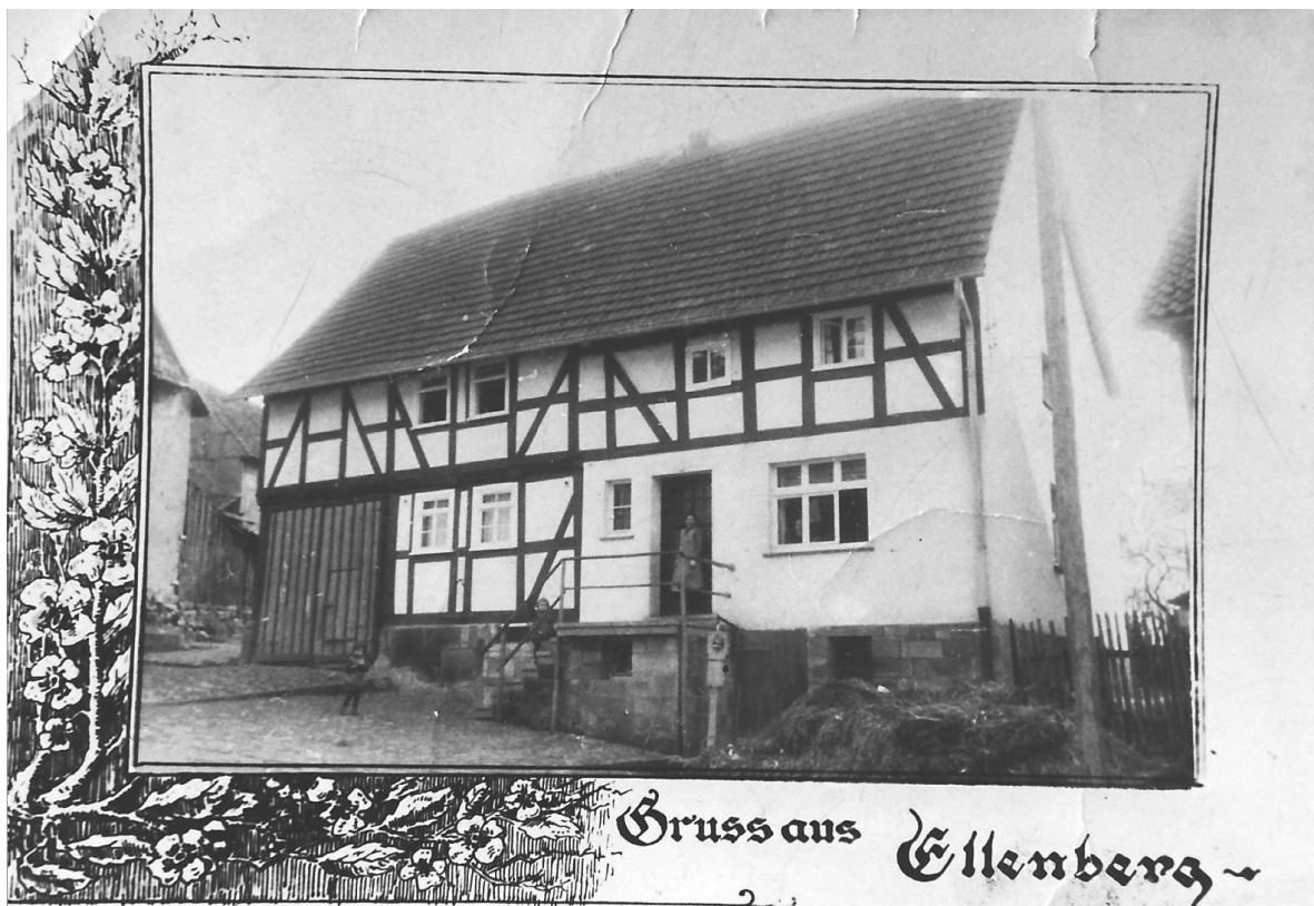
Haus Schäfer (Kördel) Brunslarer Straße
