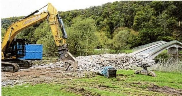
**Abbrucharbeiten mit dem Pulverisierer:** In Büchenwerra wird derzeit die Fulda-Brücke abgebrochen. Noch etwa sechs Wochen werden diese Arbeiten dauern. Danach wird an selber Stelle die neue Brücke errichtet.
