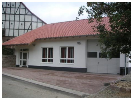
DGH - Feuerwehrgerätehaus zum Bruch
